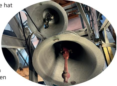
Dabei wurde festgestellt, dass die Glocken selbst noch viele Jahre funktionieren werden. Allerdings sind die „Joche“ (Stahlträger an denen die Glocken aufgehangen sind) reparaturbedürftig.
